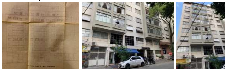
Fig 11 a 13 - Prancha de prefeitura referente a elevação frontal para rua Fortunato. Fotos atuais do edifício (autor)
