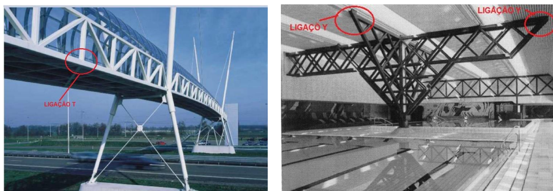
Figura 1 – Exemplo de ligação tubular tipo T e Y
